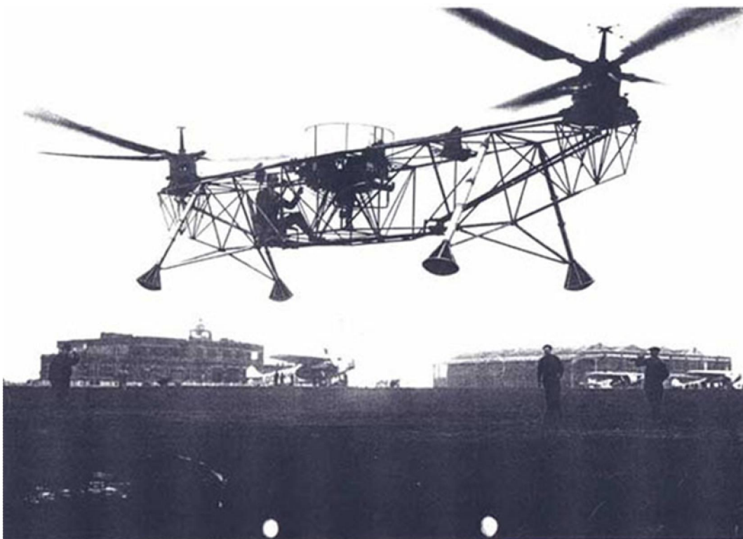
Op 4 mei 1934 vliegt de Florine II (die sedert de lente van 1933 reeds meer dan 30 vluchten had uitgevoerd) boven het vliegveld van Haren, te noorden van Brussel. Men bemerkt de aluminium beplating die later werd toegevoegd om de koeling van de motor te verbeteren. Enkele ogenblikken later zal de helikopter neerstorten op het gras ten gevolg van een accidenteel slippen van één van de centrifugale koppelingen gemonteerd op de overbrengingsas. Hierdoor verloor Robert Collin de controle over de helikopter.
