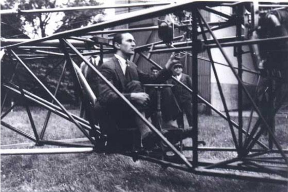
Robert Collin gezeten aan de sturen van de Florine II. Op de stuurknuppel bemerkt men een horizontaal geplaatst wiel. Door er aan te draaien regelt de piloot de collectieve pas van de beide rotors.
