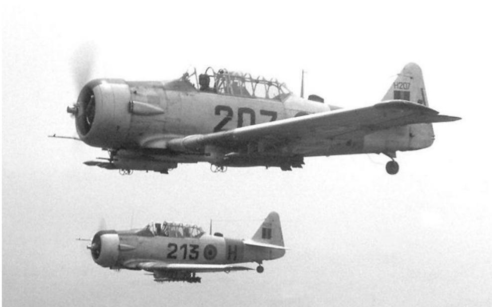
Deux T-6A en vol avec mitrailleuses et roquettes
