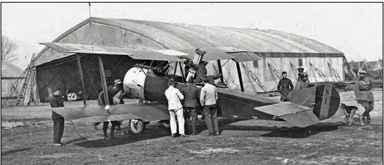
Het monteren van een camera met grote brandpuntafstand in de cockpit van de waarnemer-operator in het vliegtuig Sopwith "1,5 Strutter" nr S-1 van het 4 de Escadrille. (Verzameling Georges Lecomte via Mevrouw Laure Gisseleire zuster van Albert Gieseleire, piloot in het 4 de Escadrille en gesneuveld tijdens een luchtgevecht op 3 oktober 1918).
