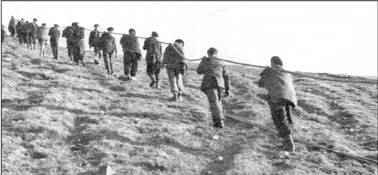
Om de draad van Mendive te herstellen wordt de nieuwe kabel op de schouder gedragen.
