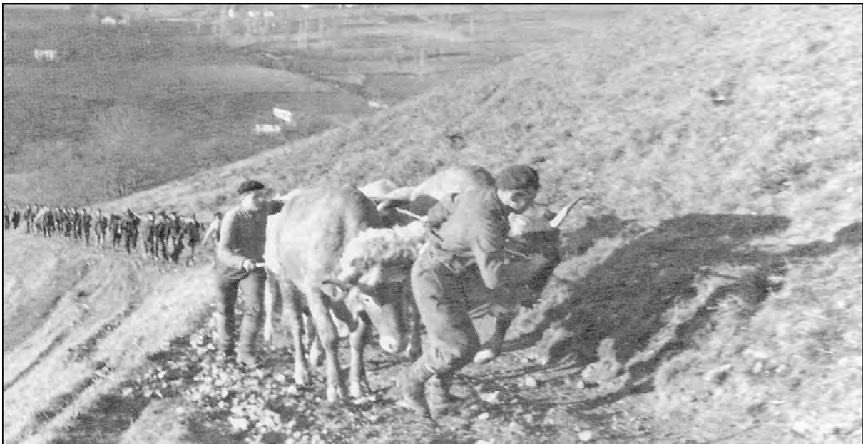
Een ossenspan trekt de kabel naar de top van de hellingen van de Iraty.
