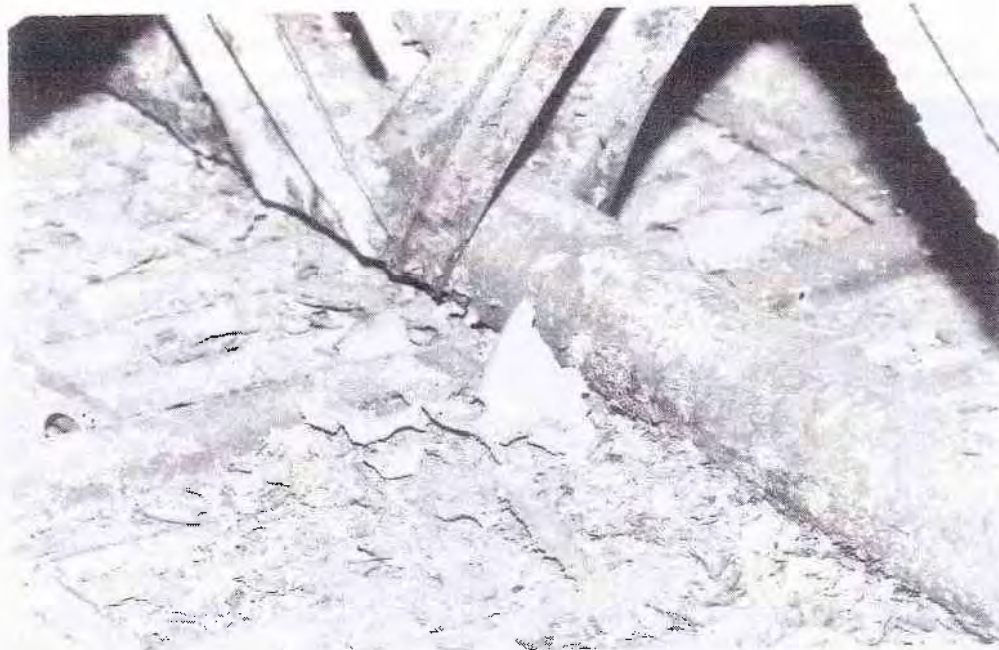
Etat de l'aile avant restauration — Staat van de vleugel vóór restauratie
