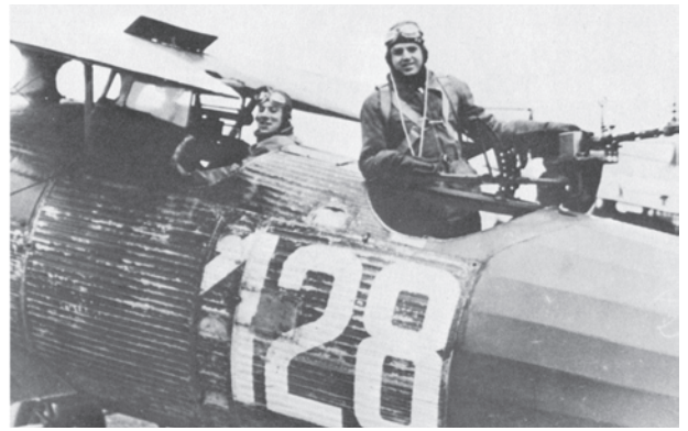
Bréguet XIX. Vue rapprochée des postes du pilote et de l'observateur. (photo MRA)
