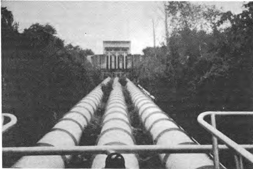
Centrale hydroélectrique de la Kilubi (Photo Willy Schaut)
