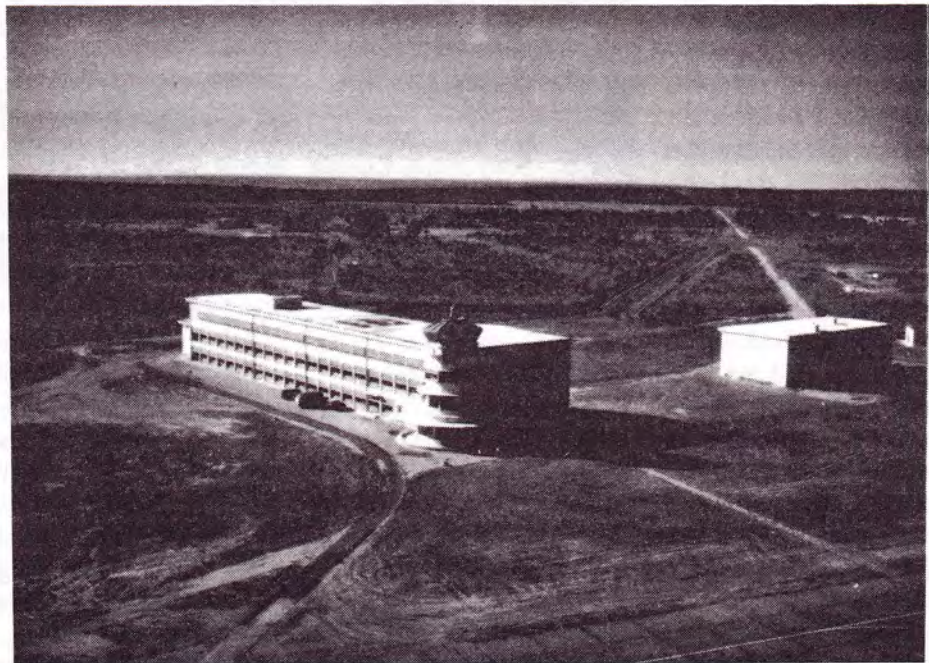
Aérogare militaire (à droite, le bloc "Emergency") - Militaireluchthaven (rechts, het bloc "Emergency")
